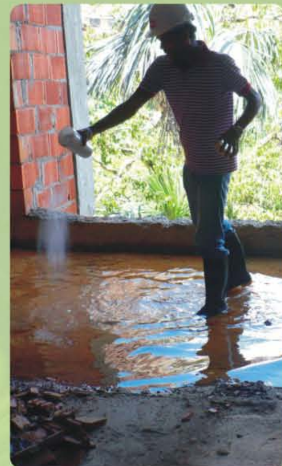
Figura 4. Tratamento de área alagadas nas lajes com o produto cal e cloro.
